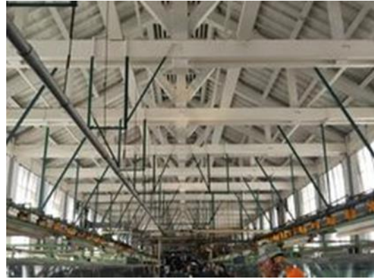
▲繰糸所（トラス構造・ガラス窓）
